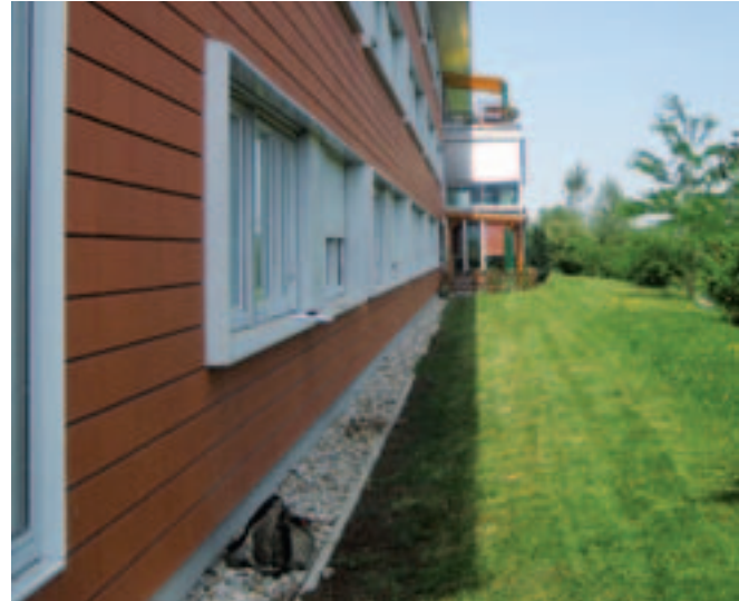
Beispiel: Extensiv gepflegte Wiesenfläche/Böschung hinter dem PH mit Strauchgruppen als Blickfang vom HBW Zimmer aus.
