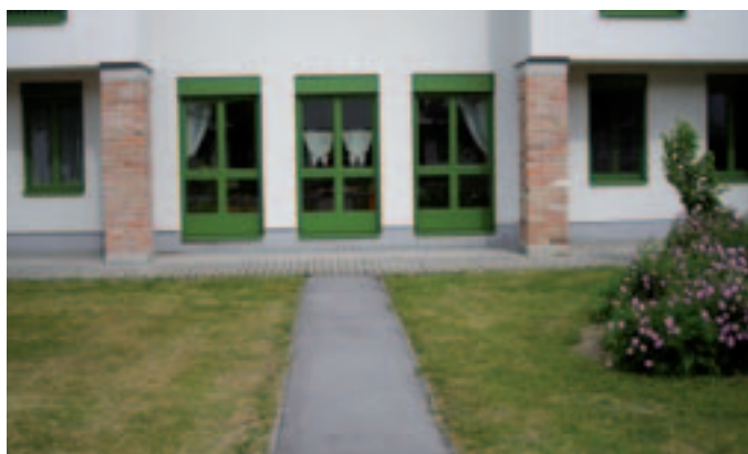
Blick von Außen
