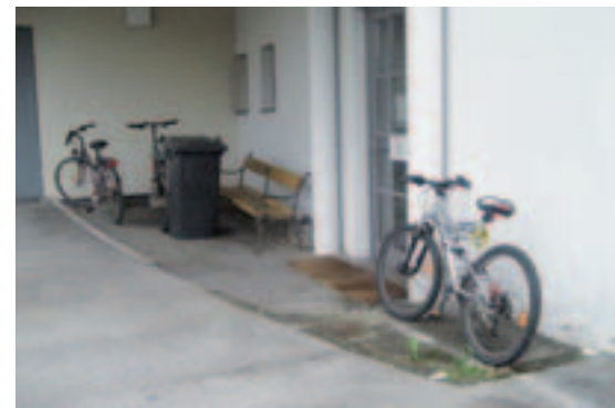
Beispiel: Überdachter Personaleingang mit Mehrfachnutzung, u. a. Fahrradabstellmöglichkeit.
