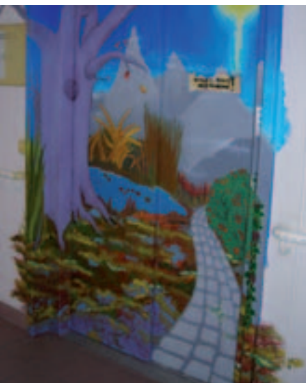
Beispiel: „Versteckte“ Aufzugstüren erleichtern die Betreuung von BewohnerInnen mit Weglaufftendenz.
