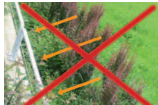
Beispiel: Eine Böschung um einen Lichthof wurde im Nachhinein geschaffen, um die vorgeschriebene Brüstungshöhe zum Lichthof zu erreichen. Die so erzeugten Restflächen mit Berberitzen zu bepflanzen, erschwert die Pflege der Böschung zusätzlich.
