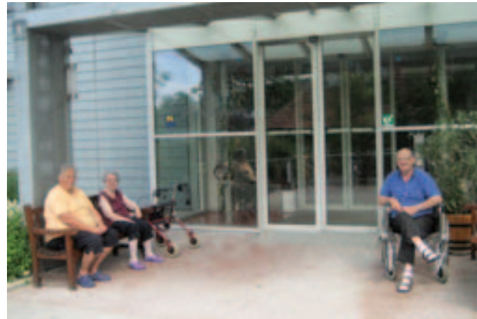
Beispiel: Haupteingang ins Gebäude, überdacht mit rutschhemmenden Bodenbelag, Sitzgelegenheiten und Platz für Rollator und RollstuhlfahrerInnen.
