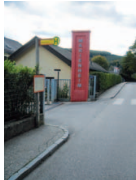
Beispiel: Eine nicht ausreichend dimensionierte und witterungsgeschützten Bushaltestelle vor einem PH, die auch nicht barrierefrei ausgeführt ist.
