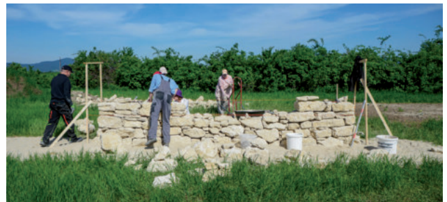
Szárazon rakott kőfal alapozása és megépítése.
