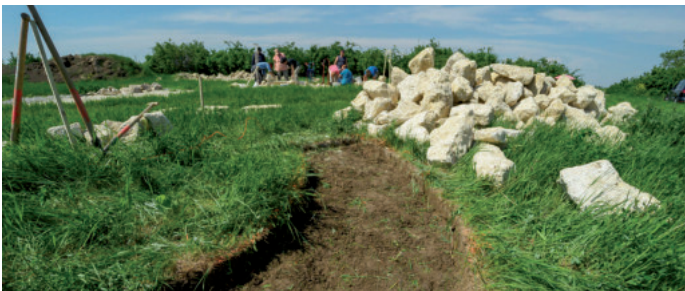
Szárazon rakott kőfal alapozása és megépítése.
