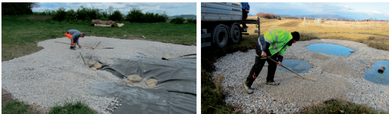
Kerti tó építése tófólia használatával.
