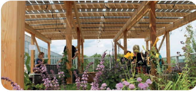
Abb. 7: PV-Dachgarten (© Verband für Bauwerksbegrünung, BOKU WIEN, IBLB)
