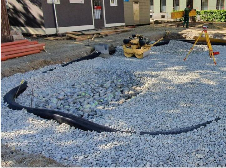
Verteil- und Belüftungsschicht.
