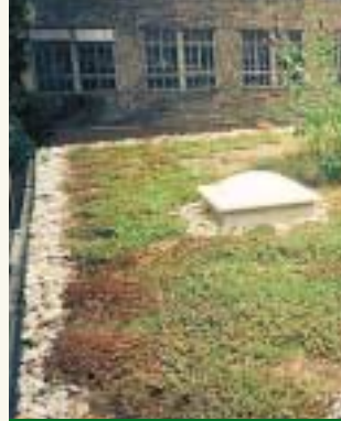
Brandschutzstreifen aus Kies
