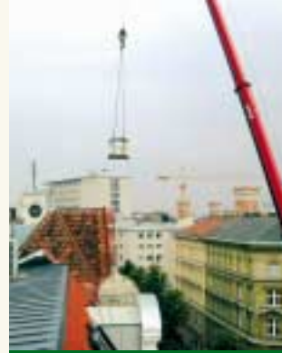
Mit einem Big Bag wird das Substrat aufs Dach gehoben.
