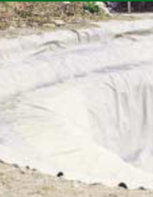
Schutzvlies fertig verlegt
