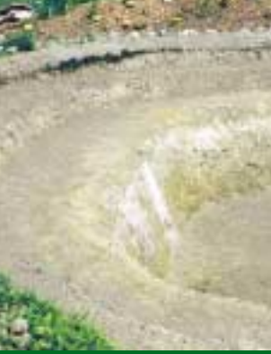
Aushub in Stufen
