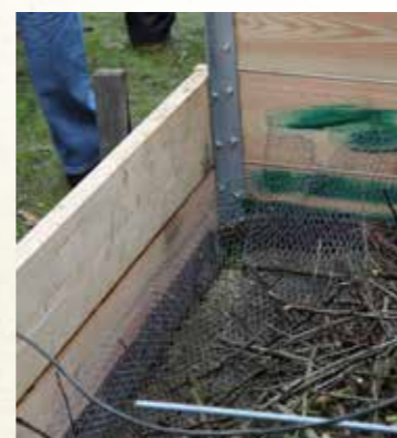
Einbau eines Wühlmausgitters
