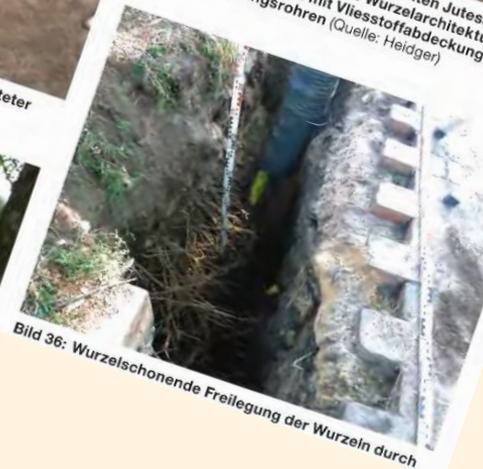
Bild 36: Wurzelschonende Freilegung der Wurzeln durch
