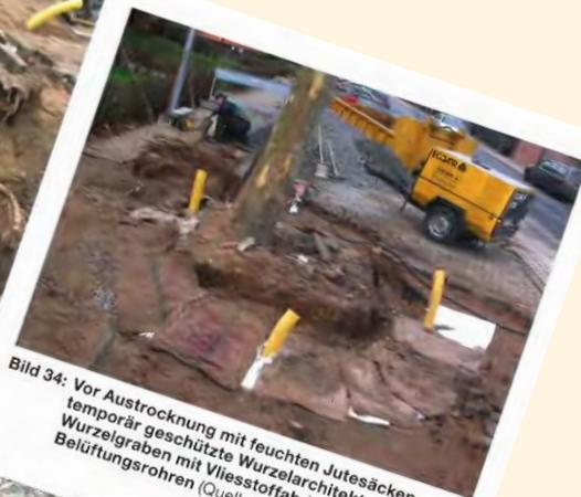
Bild 34: Vor Austrocknung mit feuchten Jutesäcken temporär geschützte Wurzelarchitektur im Wurzelgraben mit Vliesstoffabdeckung und Belüftungsrohren (Quelle: Heidger)
