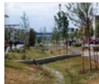
Sicker-Speicher-Teich (Foto: Dreiseitl)
