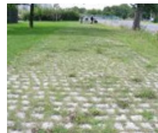
Durchlässige Wegedecke (Foto: Kumpfmüller)
