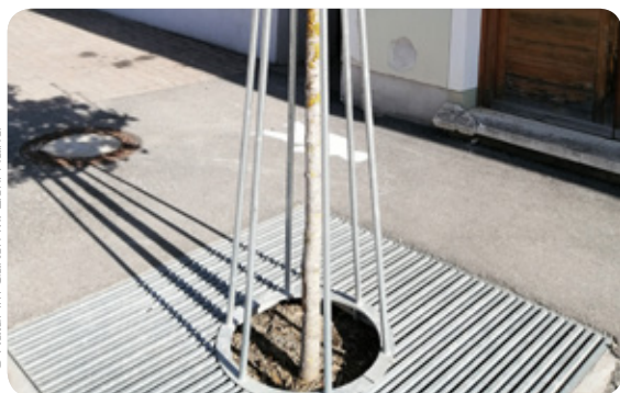
Geschützte Baumscheiben bestehen aus Metallrosten die belastungsstabil sind und Versickerung zulassen.
